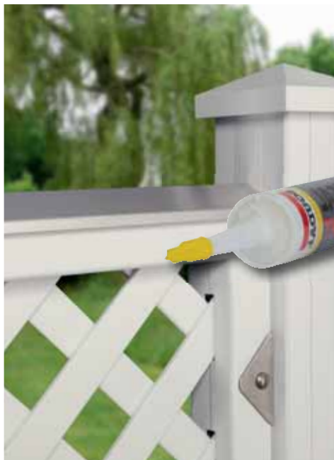
Fixer le profilé de finition design en aluminium avec la colle MS polymère (1398).
