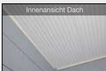
Geschäumte Dachisolierung (42 mm)
